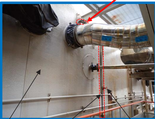
タービン建屋(壁面)
