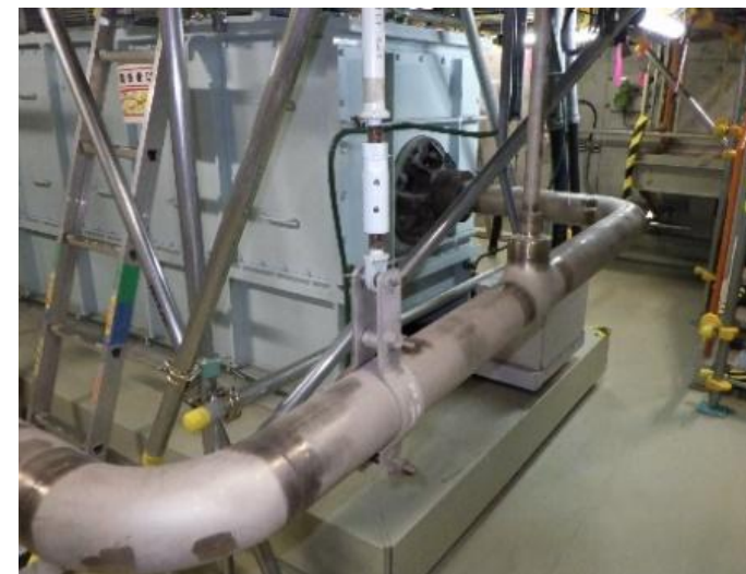
予熱・保温設備（解体後）
