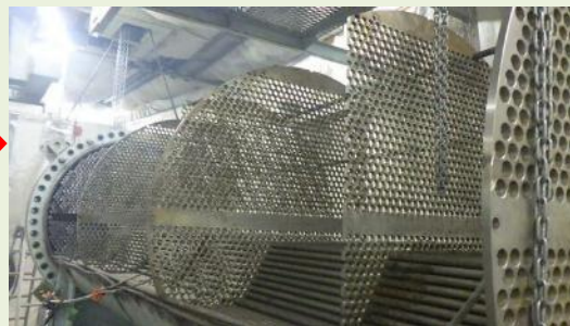
解体撤去作業中
