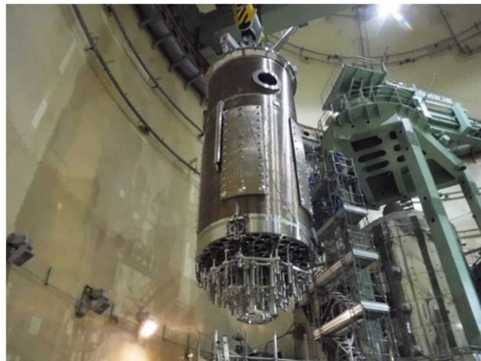
格納容器内を移動中の新しい炉内構造物(美浜発電所3号機、2020)
