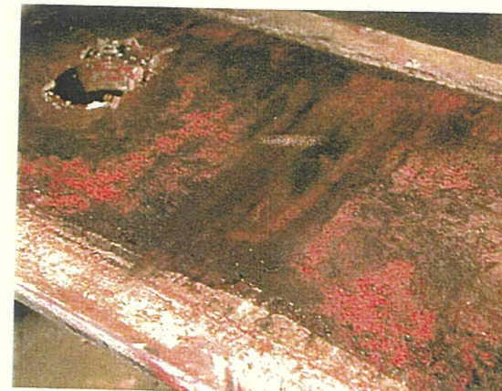
写真5：架台上部側（中央）
