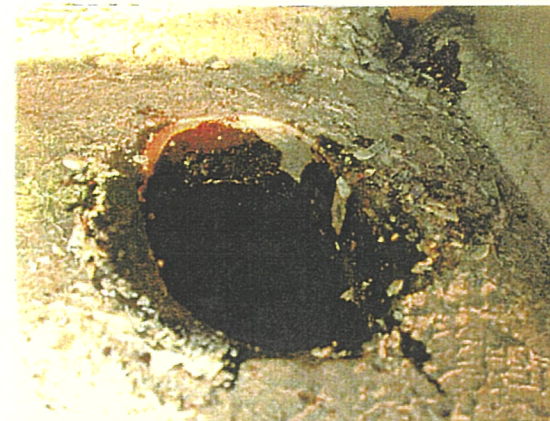
写真1：支持脚上部側（右）
