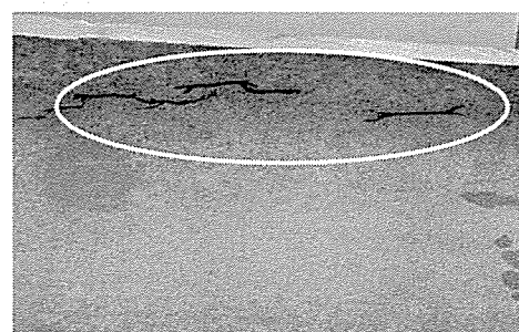
内面観察写真(浸透探傷試験結果)
