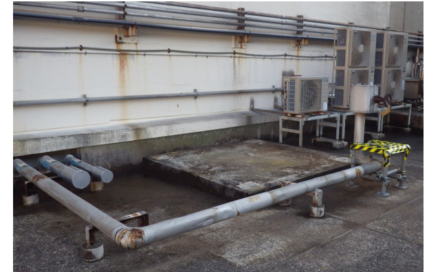
[膨張タンク解体後]
