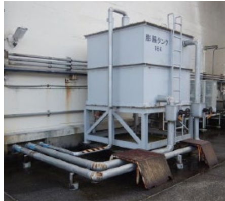
[膨張タンク解体前]
