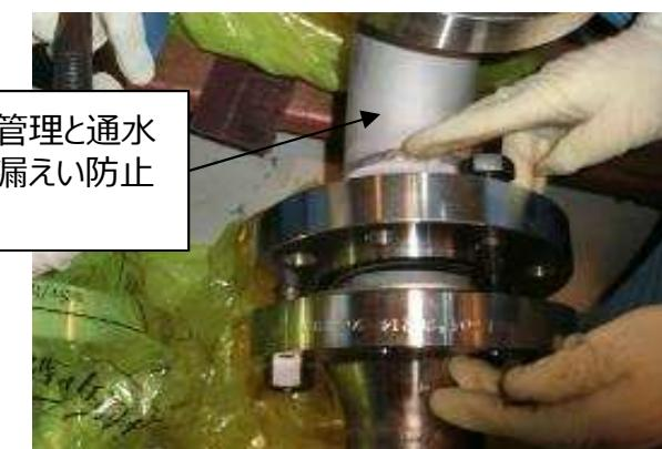
適切な締付管理と通水確認により、漏えい防止を図る。
