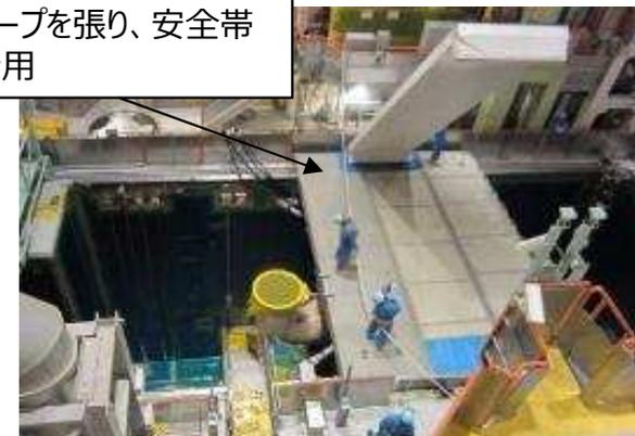
原子炉キャビティ上に仮設床を設置
