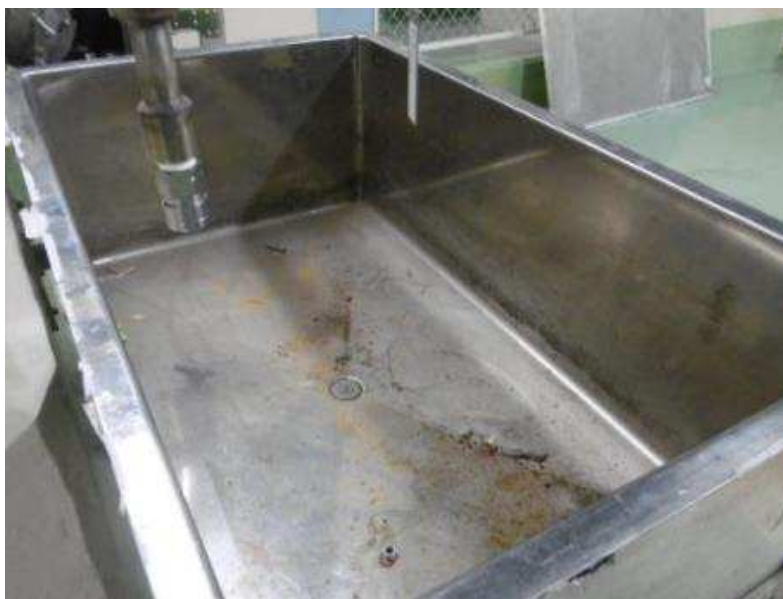
除染前（除染槽）
