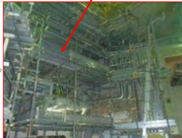
高所設置機器を解体する ため、仮設足場を設置し、 作業終了後に撤去
