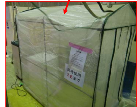
熱中症防止用仮設ハウスを設置 (内部を冷却)
