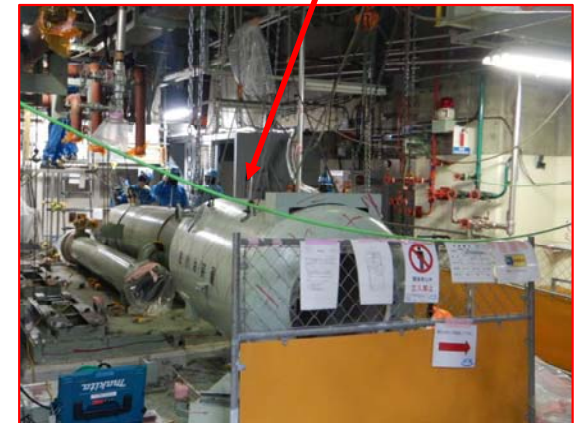
密封油装置撤去状況 油タンクを解体中
