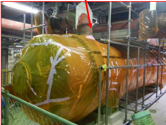
熱交換器撤去状況 熱交換器の保温材を撤去
