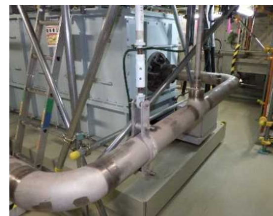
予熱・保温設備（解体後）
