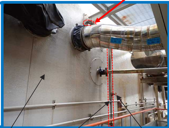
タービン建屋(壁面)
