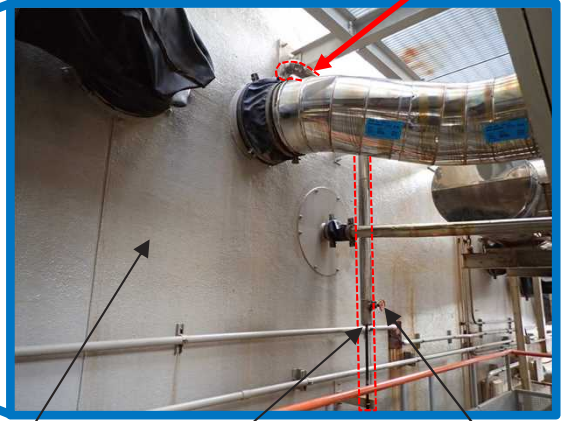
タービン建屋(壁面)
