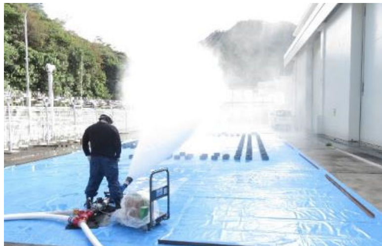
スプレイヘッド 機能性能検査（使用済燃料ピット漏えい対応）
