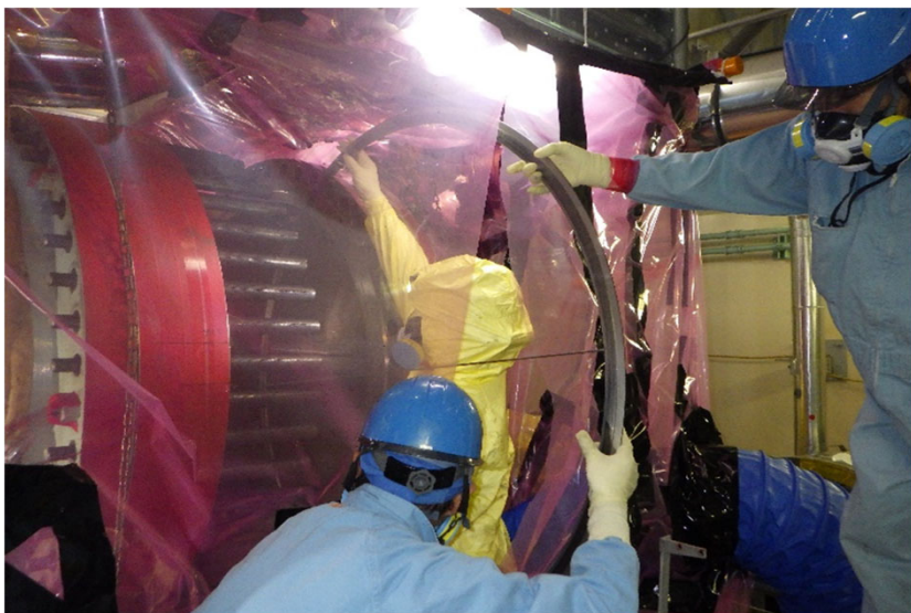
余熱除去クーラ開放点検（水室側ガスケット取替作業）
