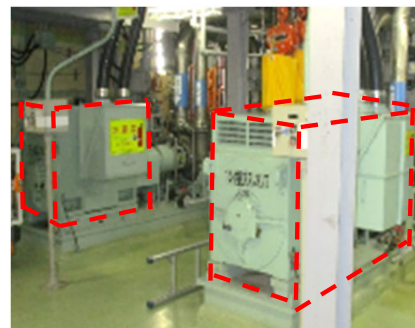
モータ解体前
