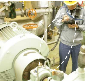
【軸受部の振動確認の例】
