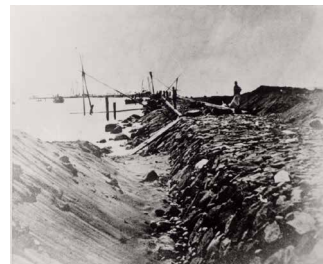
突堤工事の様子 (明治12（1879）年頃)
