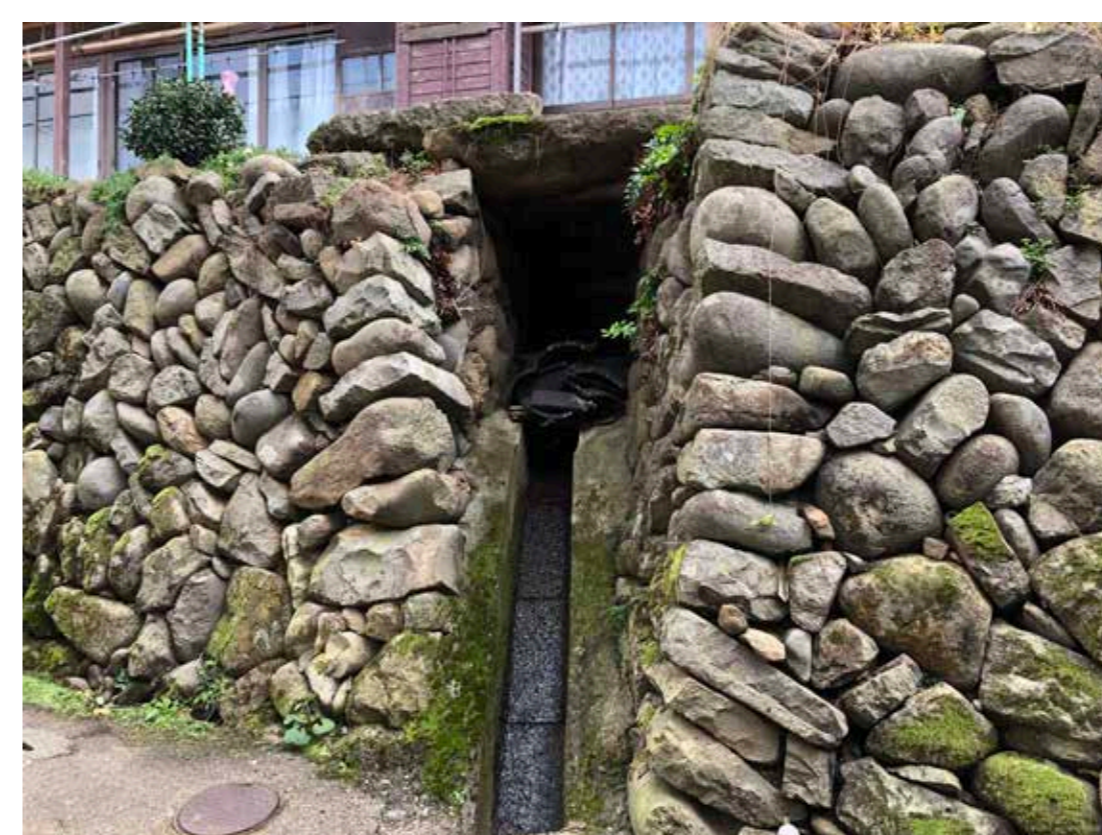
斜面地の集落に見られる石積み擁壁は、 平地を作り、土地を有効に利用するため
