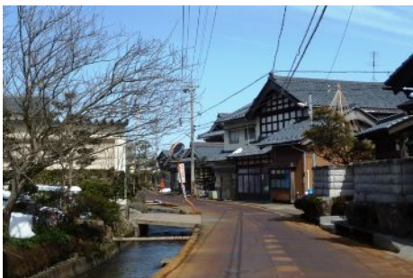
七郷用水沿いに建ち並ぶ白壁民家（福井市在田町）
