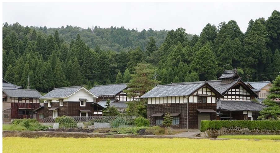
土蔵と一体となった白壁の民家（越前町岩開）
