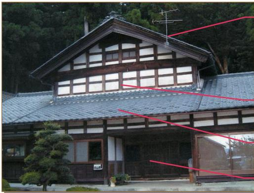
〈屋根〉切妻屋根・瓦葺き（嶺北は越前瓦葺き）
