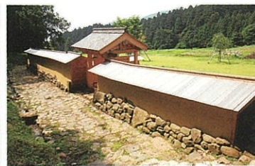
僧坊の門と土塀が復元され、史跡の整備が進められている。
