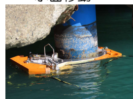
鋼管杭の把持
