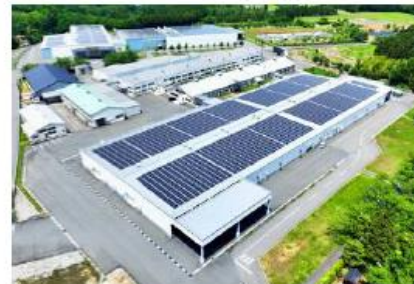
細呂木工場の太陽光オンサイトPPA。写真手前の工場は2021年3月から、奥の工場は2023年3月から稼働。合わせて年間900トン超のCO 2 を削減する。
