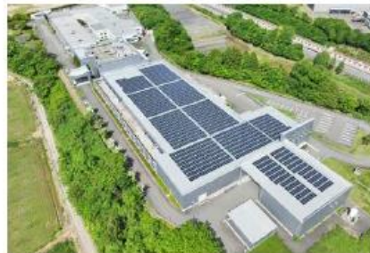
2022年2月から太陽光発電が稼働した加賀工場。年間300トン近いCO 2 を削減する。
