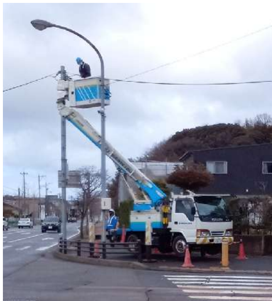
道路照明の更新 (イメージ)
