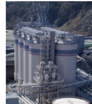
北陸電力敦賀火力発電所 バイオマス燃料貯蔵サイロ
