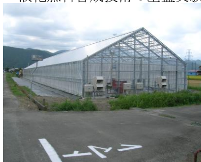
高効率ヒートポンプ空調の実証試験栽培ハウス
