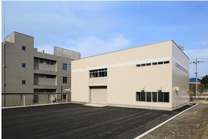
原子力安全システム研究所 熱流動実験棟
