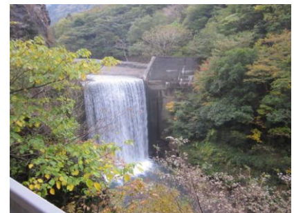
砂防堰堤の一例
