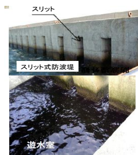
スリット式防波堤の例
