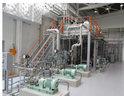
保修訓練設備（ルーブ設備）
