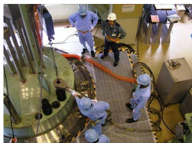
モックアップ設備による保守訓練
