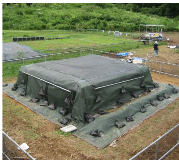
汚染水の拡散を防ぐ高強度の遮水シート
