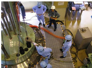
モックアップ設備による保守訓練
