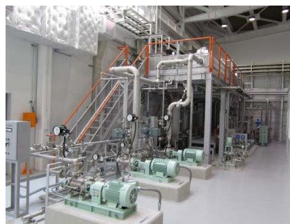
保守訓練設備 (ルーブ設備)
