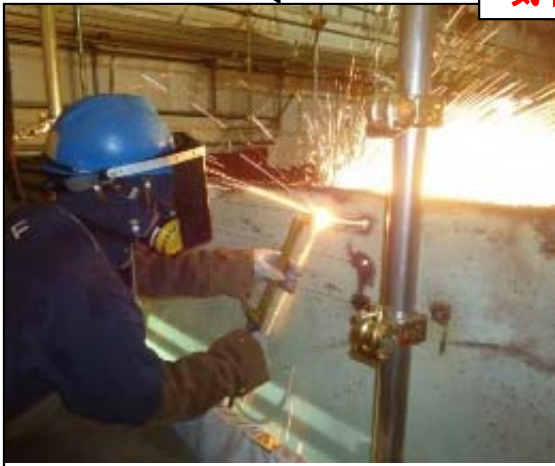
熱的切断工法による切断実証
