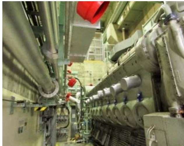
機械工作室エリア周辺機器等の解体
