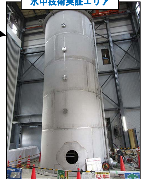
水中タンク (高さ約10.5m, 外径約4.5m)
