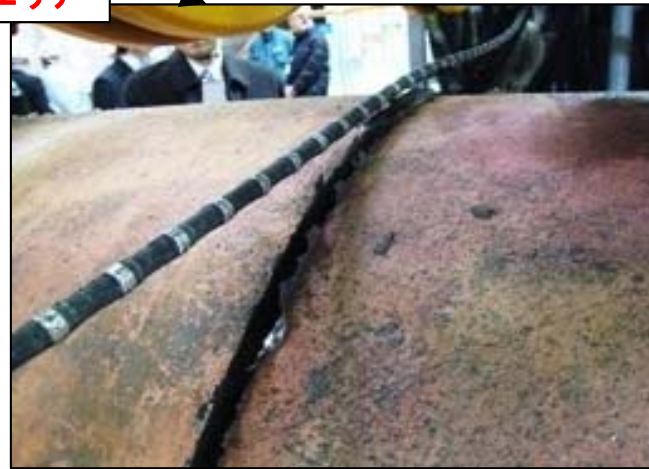
機械切断工法による切断実証
