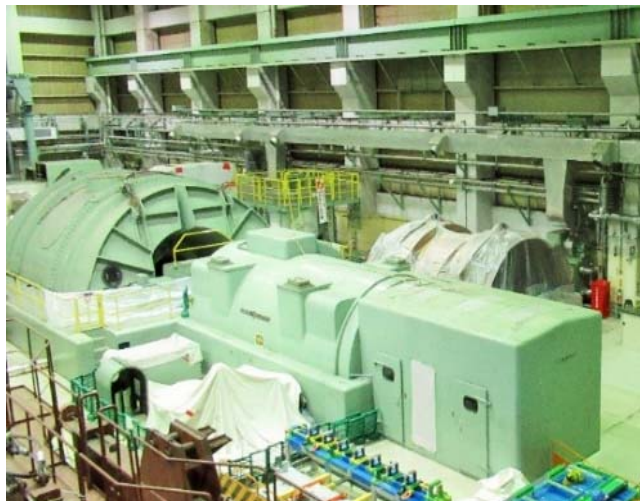
タービン・発電機等の解体
