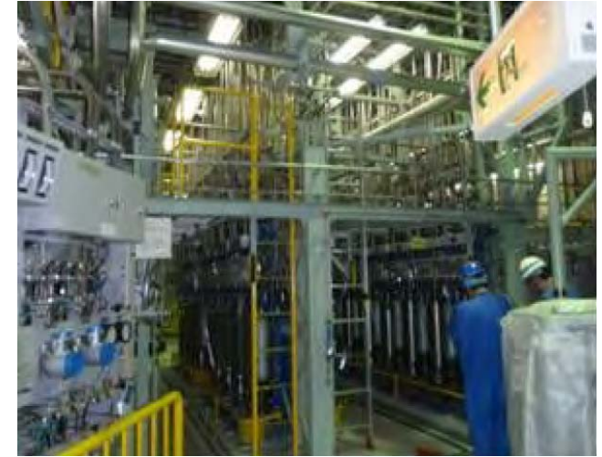
制御棒駆動ユニット等の解体
