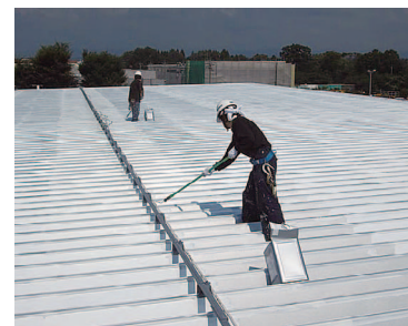
〈遮熱塗料の施工状況〉
