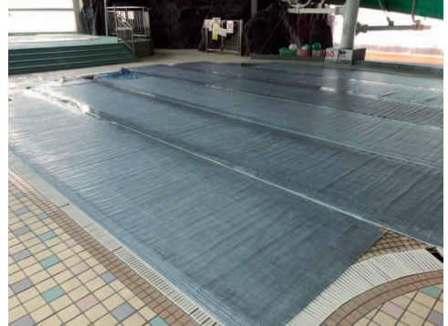
〈プールへの保温シート設置〉
