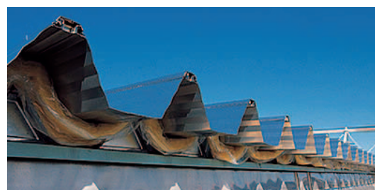
〈ダブル折板の施工風景〉
