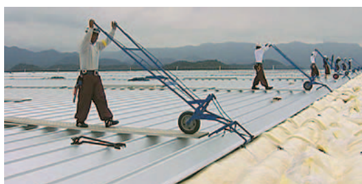
〈ダブル折板の施工風景〉
