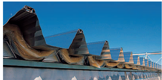
ダブル折板の施工風景
