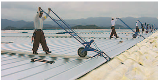
ダブル折板の施工風景
