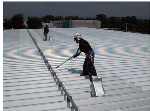
遮熱塗料の施工状況 出典：ミラクール HP
