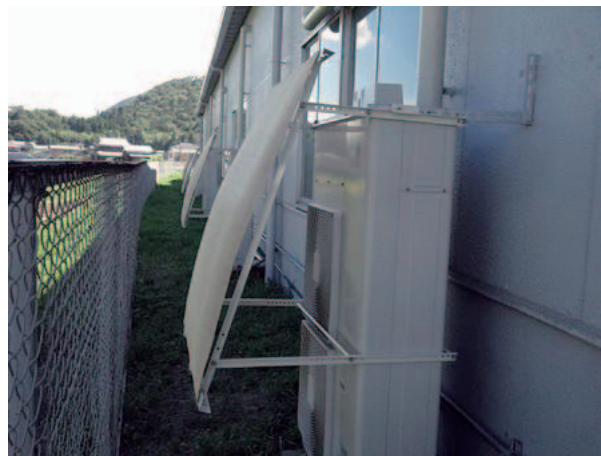
〈室外機への日除け取付け〉
