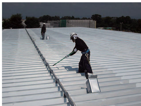
〈遮熱塗料の施工状況〉
