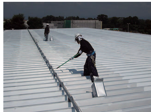
〈遮熱塗料の施工状況〉
