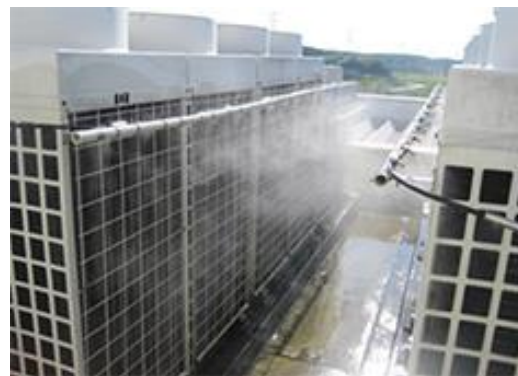
出典:中村商会 HP 散水システムの特徴 散水装置の稼働時状況
