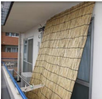
出典:ダイキン HP 室外機の日除け エアコンの性能を引き出す環境整備
