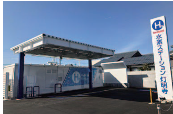
〈令和3(2021)年4月2日 開所した水素ステーション〉
