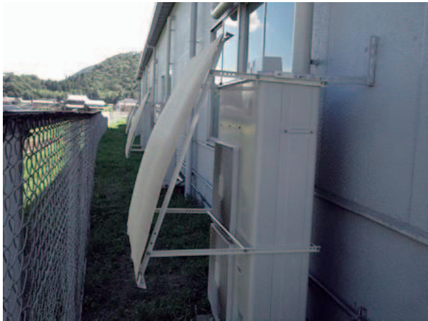
〈室外機への日除け取付け〉
