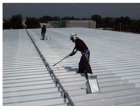
〈遮熱塗料の施工状況〉
