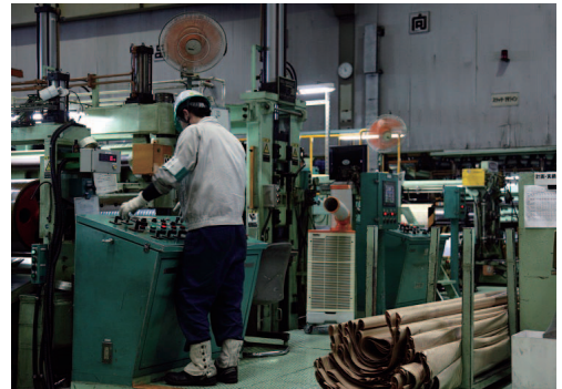
〈スポット空調の使用状況〉
