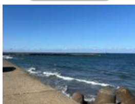
港湾施設点検
