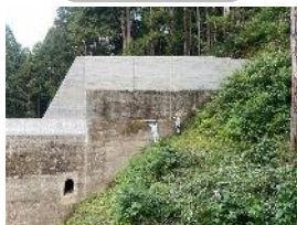
砂防施設点検
