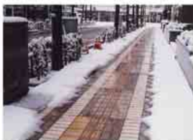
無散水消雪(福岡市)
