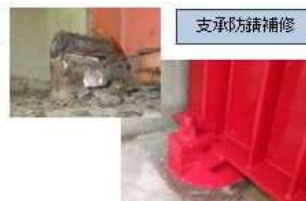
支承防錆補修
