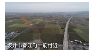
現況写真 (R4.11月時点)
