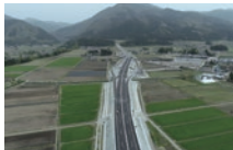
供用後の状況 荒島IC
