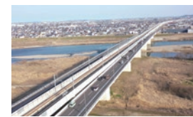
新九頭電橋 (R4.10.22 供用開始)
