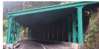
スノーシェッド補修
