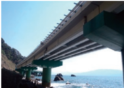
橋梁補修工事 (河野大橋)
