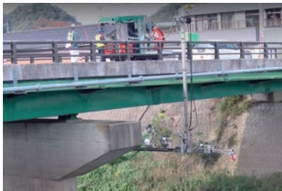
橋梁点検 (舞屋橋)
