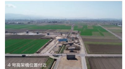
現況写真 (R5.3月時点)
