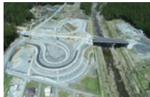
施工状況 九頭竜IC
