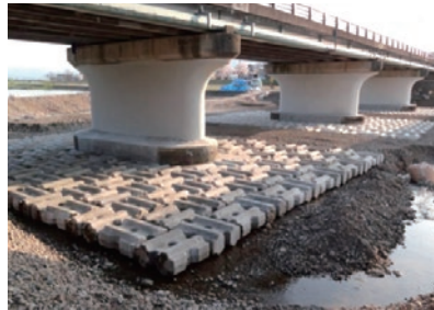
橋梁耐震補強工事 (万代橋)
