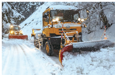
除雪作業の様子
