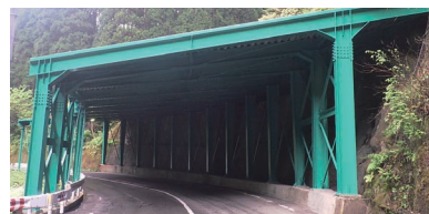
スノーシェッド補修
