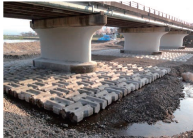
橋梁耐震補強工事 (万代橋)
