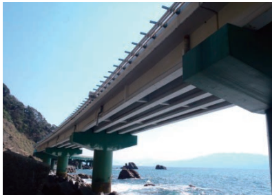
橋梁補修工事 (河野大橋)
