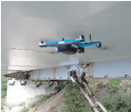
ドローンを活用した 橋梁点検
