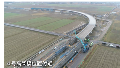
現況写真 (R8.2月時点)
