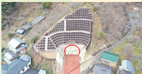
若狭町遊子 付近((仮称)小川トンネルの遊子側坑口付近)
