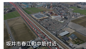
現況写真 (R8.3月時点)
