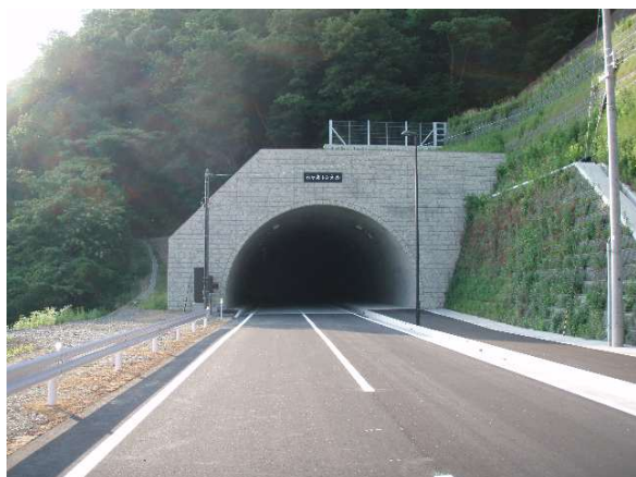
松ヶ鼻トンネル（下平吹側）
