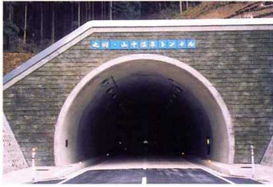
福井県側坑口
