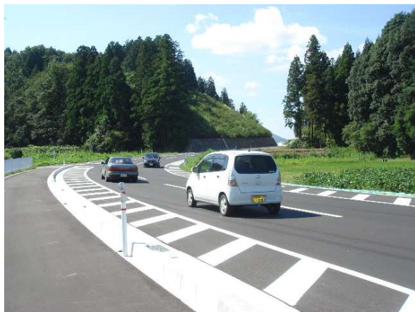
供用状況（福井市側から）
