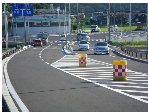
供用の状況（国道 27 号交差部）
