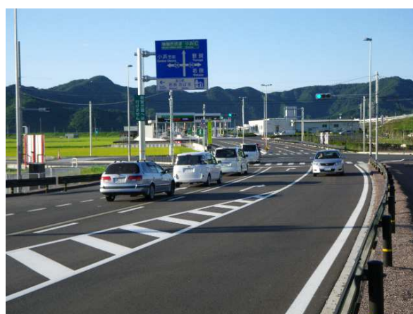
供用の状況（料金所手前）
