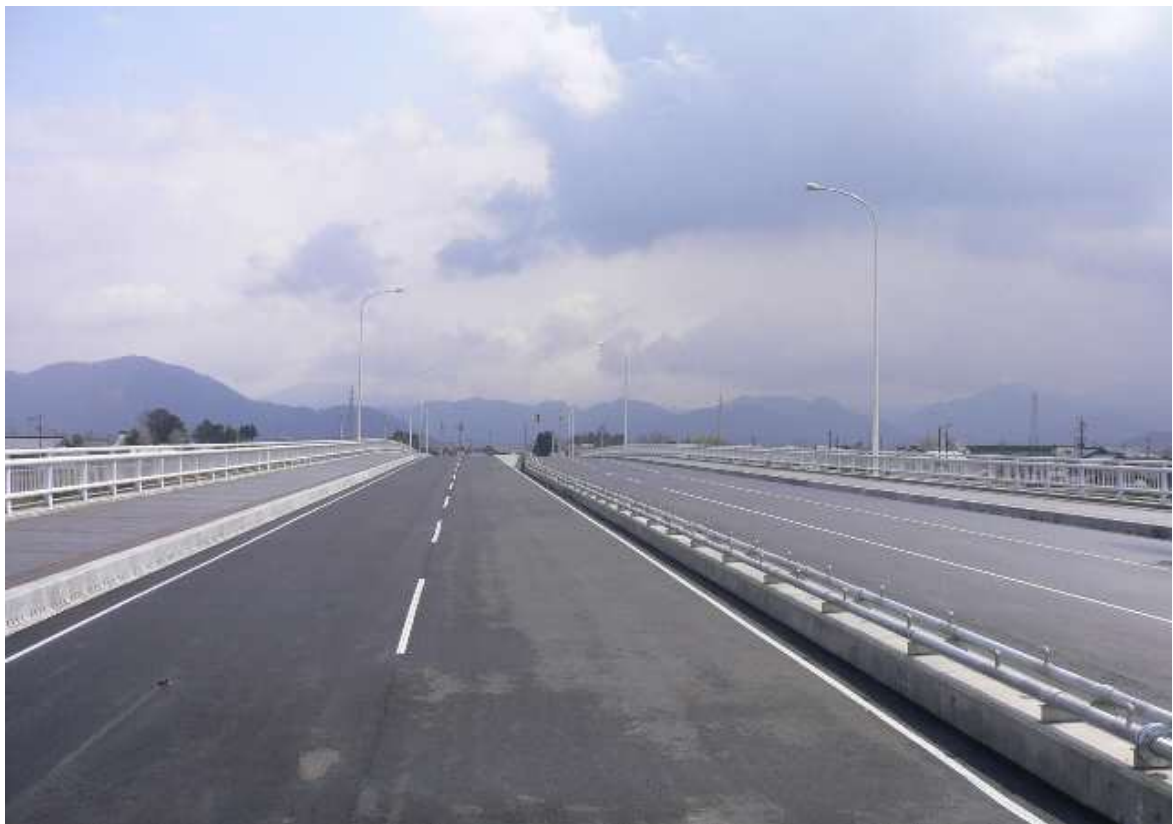
完成した府中大橋
