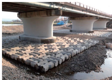
橋梁耐震補強工事 (万代橋)
