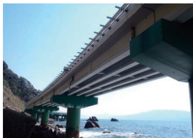
橋梁補修工事 (河野大橋)
