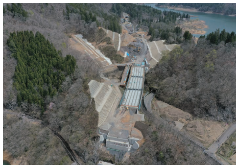
箱ヶ瀬地区施工状況(R8.4月時点)
