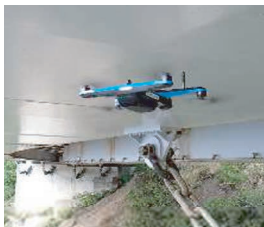
ドローンを活用した 橋梁点検
