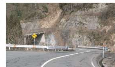
急カーブが連続する現道
