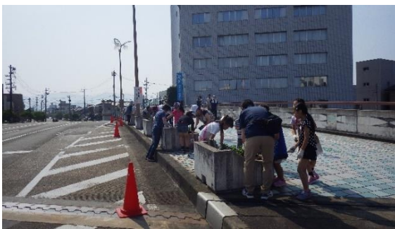
一般県道 福井停車場勝見線 城東橋（福井市手寄）
