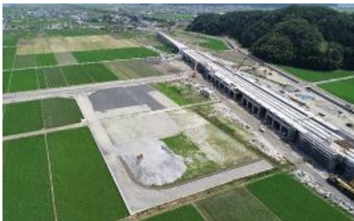
南越駅(仮称)周辺の整備状況
