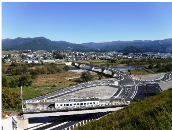
一般県道 勝山インター線 (H28年)
