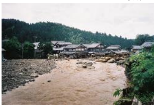
一乗谷川 被災状況
